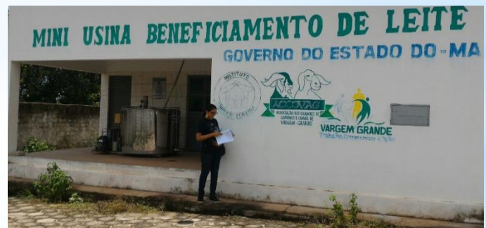
Figura 1. Laticínio abandonado em Vargem Grande
