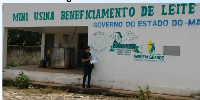
Figura 1. Laticínio abandonado em Vargem Grande.
